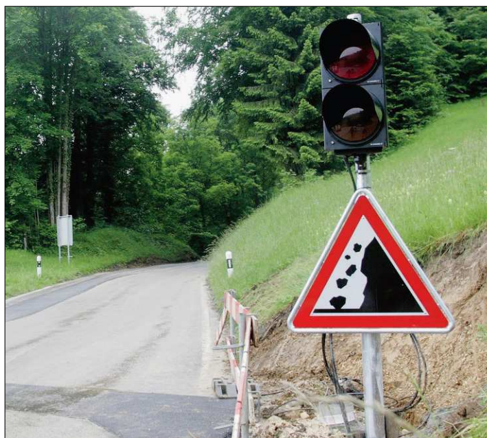
SÉCURITÉ Des feux de signalisation avertiront les usagers en cas d'éventuelles chutes de pierres. (BIST)
